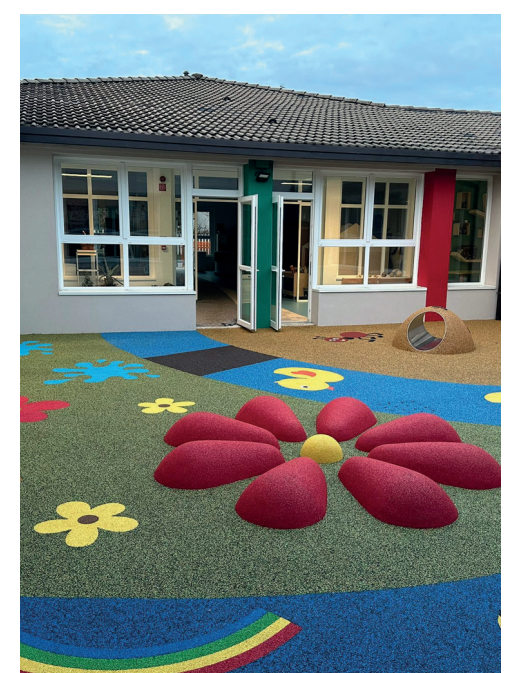
Un asilo efficientato da Ates Energia
